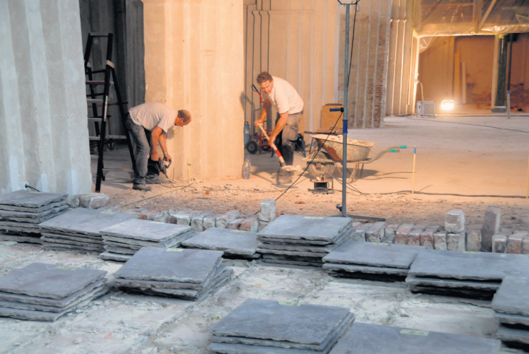
Op de foto onder is te zien hoe ook de tegels uit het koor gehaald worden. Elke tegel wordt zorgvuldig genummerd, zodat ze straks weer op identieke wijze herplaatst kunnen worden.
