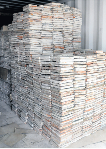
Zorgvuldig zijn de estrikken van de vloer verwijderd. (Foto hierboven) Opgestapeld liggen ze te wachten tot ze weer teruggelegd kunnen worden. (Foto rechts). Dat gebeurt na de bouwvak. In de bouwvak, op dit moment, leggen bouwvakkers de vloerverwarming aan. Dat doen ze op de blootgelegde vloer. De nieuwe vloer wordt dan ook iets hoger dan de oude vloer.
