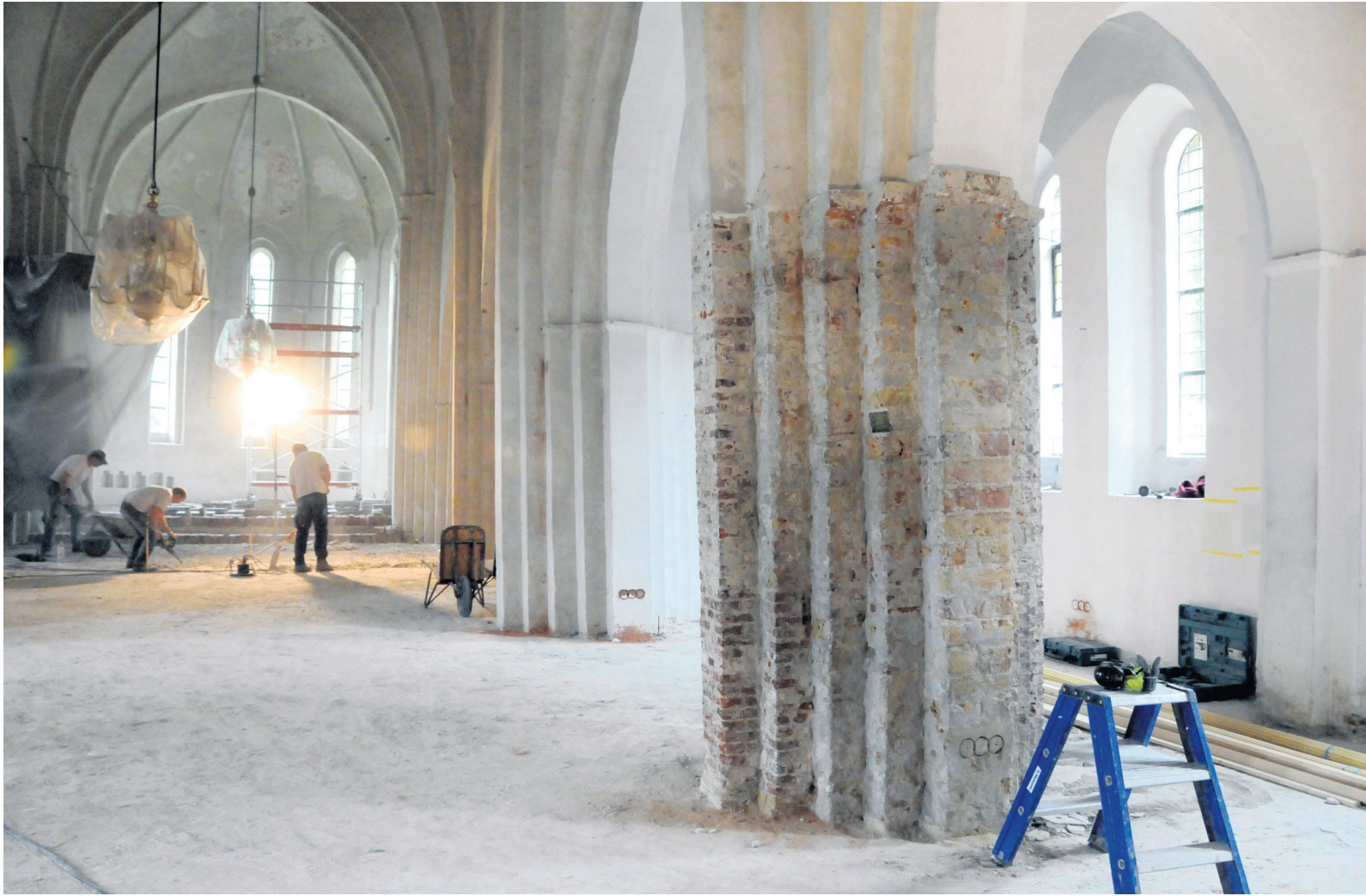
Rechts: het lek in de vloerverwarming waardoor een grote onderhoudsbeurt van de Kruiskerk noodzakelijk werd. De foto boven laat de pilaren zien waarvan het stucwerk was aangetast door het lek.
