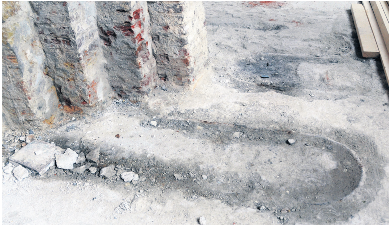
Rechts: het lek in de vloerverwarming waardoor een grote onderhoudsbeurt van de Kruiskerk noodzakelijk werd. De foto boven laat de pilaren zien waarvan het stucwerk was aangetast door het lek.
