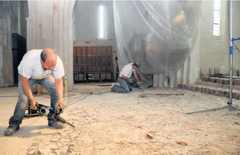
Zorgvuldig zijn de estrikken van de vloer verwijderd. (Foto hierboven) Opgestapeld liggen ze te wachten tot ze weer teruggelegd kunnen worden. (Foto rechts). Dat gebeurt na de bouwvak. In de bouwvak, op dit moment, leggen bouwvakkers de vloerverwarming aan. Dat doen ze op de blootgelegde vloer. De nieuwe vloer wordt dan ook iets hoger dan de oude vloer.
